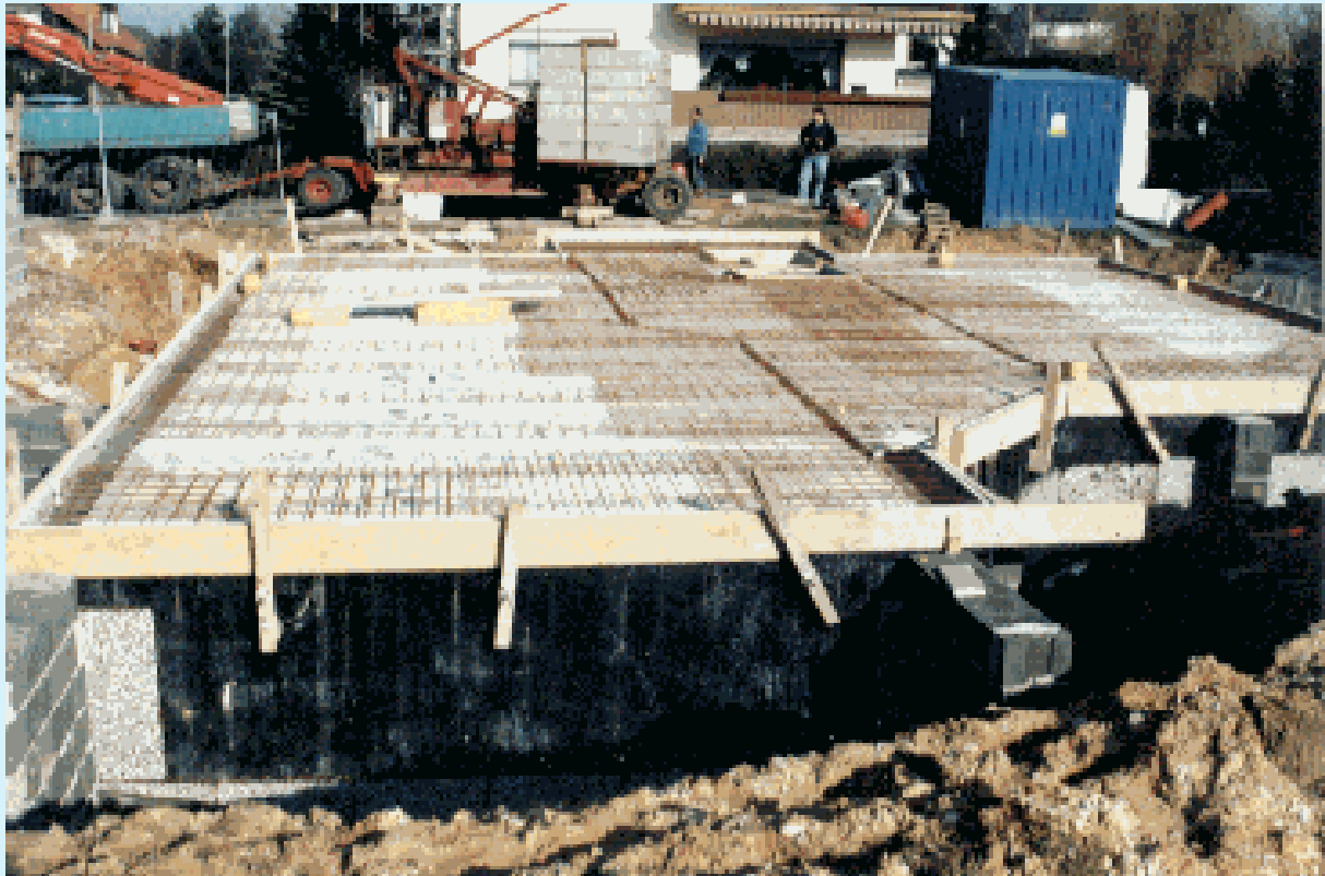
Wohnhaus mit Kellergeschoss aus Beton
