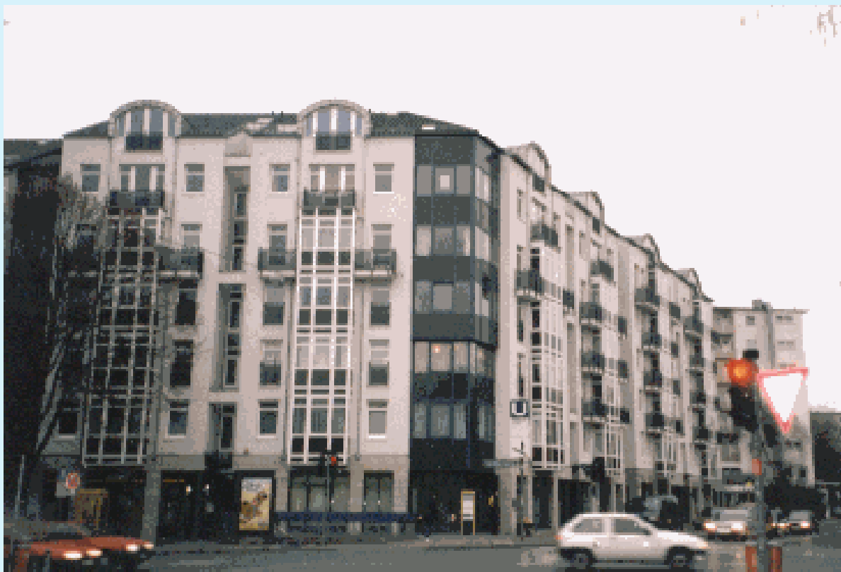
Eigentumswohnanlage mit Tiefgarage
